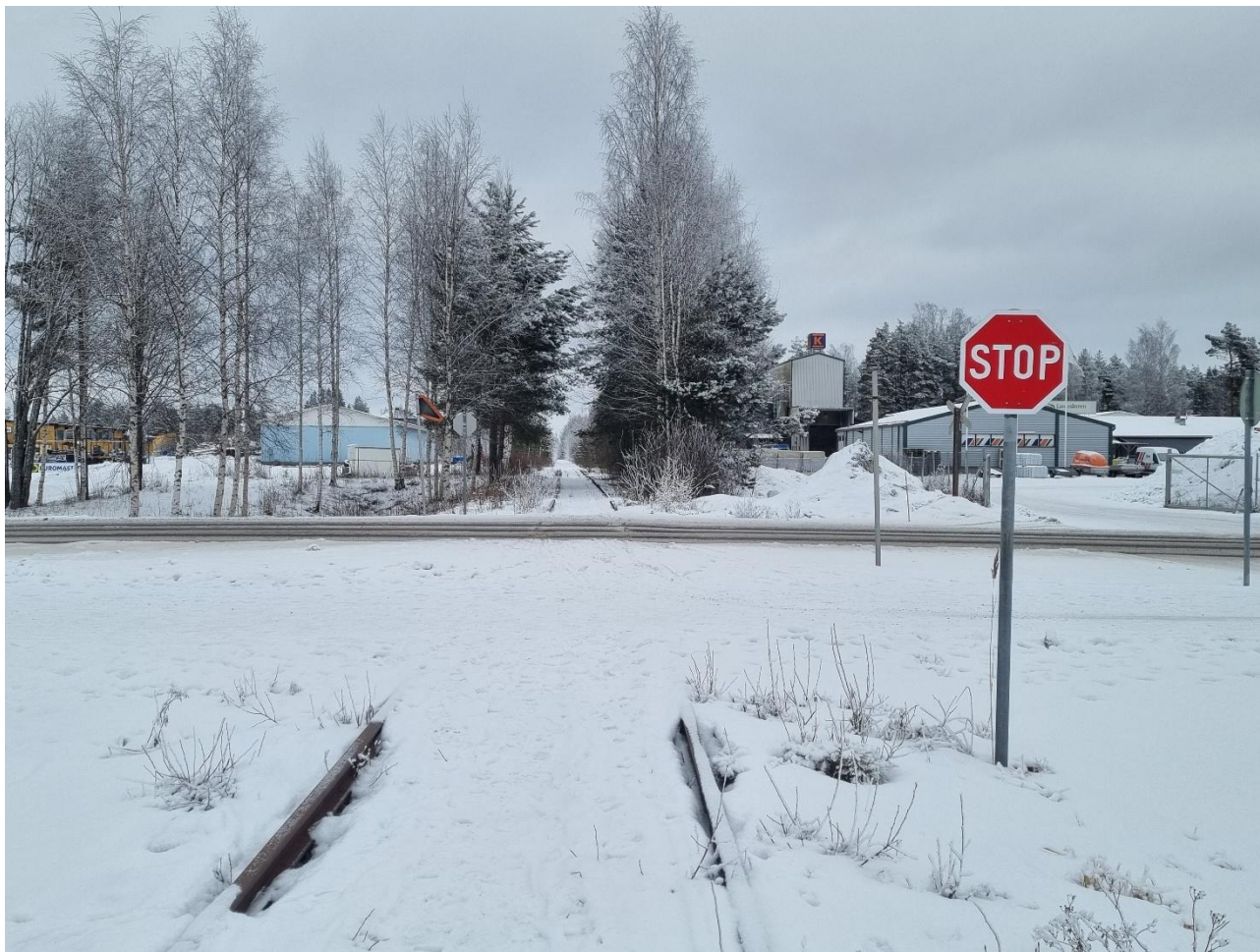
Kuva 4-1. PPH-rataosalla on lukuisia tasoristeyksiä, joista osasta on poistettu kiskot ajoradan kohdalta. Rautatienkatu, Kankaanpää. (Kuva: Janne Kojo, 2025)
