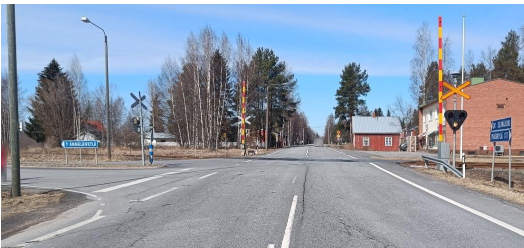
Kuva 9. Kouran tasoristeys, jossa on haasteena tasoristeuksen läheinen tieliittymä. Kuva: Väylävirasto.
