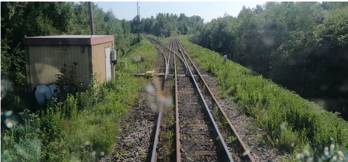
Kuva 9. Suomalaisen raidelevyden vaihde Röttän radan erkanemispaikassa (Lähde: Ratakuvapalvelu, ennen kohteen sähköistystä).
