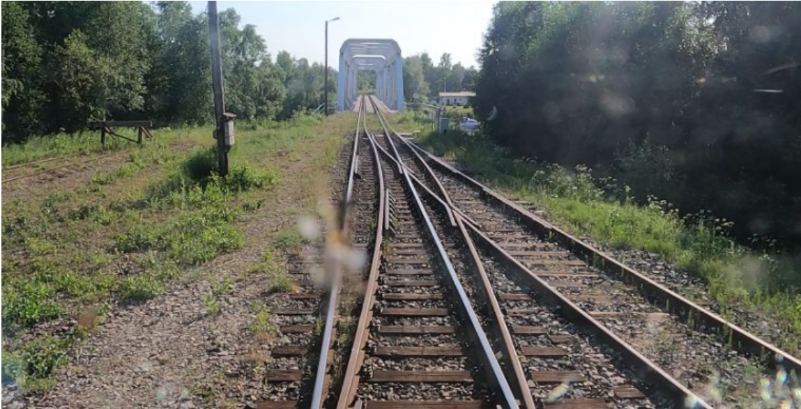
Kuva 8. Eurooppalaisen raidelevyden vaihde Tornion ratapihan eteläpäässä (Lähde: Ratakuvapalvelu, ennen kohteen sähköistystä).
